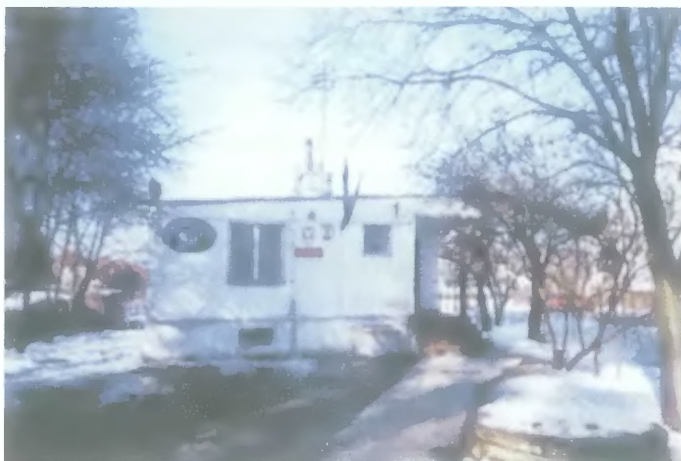
Budynek poczty w Komorowie - stan obecny (zima 2003)
